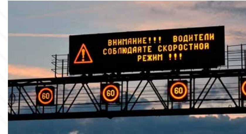
СИСТЕМА ОПОВЕЩЕНИЯ ВОДИТЕЛЕЙ (ЗНАКИ ПЕРЕМЕННОЙ ИНФОРМАЦИИ, ТАБЛО ОБРАТНОЙ СВЯЗИ)
