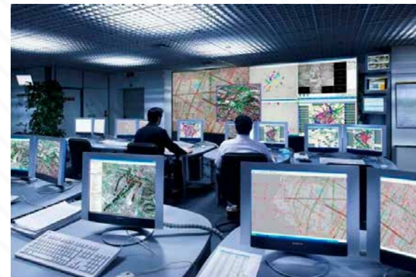
Аппаратно-программный комплекс, устанавливаемый в Центре управления ИТС
