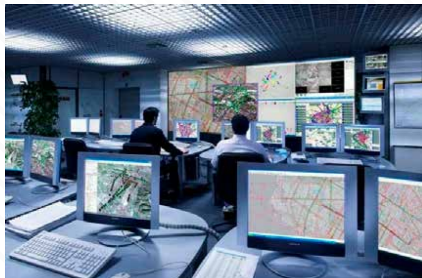
Аппаратно-программный комплекс, устанавливаемый в Центре управления ИТС
